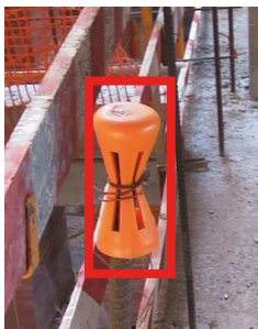
დიაგრამა 5. არმატურის დასაცვლი საყრდენები, რომლებიც საფრთხის შემცველია. დიაგრამა 6. არმატურის დასაცვლი, რომელზე დაეყრდნობა გამოწვეული ტრავმის ალბათობა შემცირებულია
