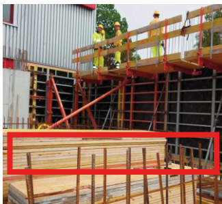
დიაგრამა 5. არმატურის დასაცვლი საყრდენები, რომლებიც საფრთხის შემცველია. დიაგრამა 6. არმატურის დასაცვლი, რომელზე დაეყრდნობა გამოწვეული ტრავმის ალბათობა შემცირებულია
