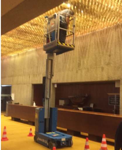
დიაგრამა 18. მობილური ამალე- ბული პლატფორმა გამოიყენება ოფისში განათების შესაცვლელად
