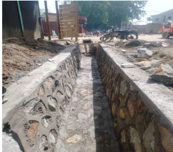
Photo : produit fini d'une sous section de fossé
