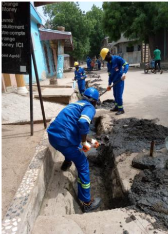
Photo : Séance de curage des fossés.
