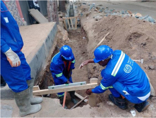
Photo : mise en gabarit des fossé
