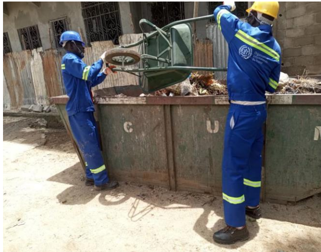
Photo : Collecte des déchets solides. Dépôt des déchets dans le bac de stockage à ordures provisoire éloignable de 3000 litres, mise à la disposition par le Maire de la ville de Maroua.
